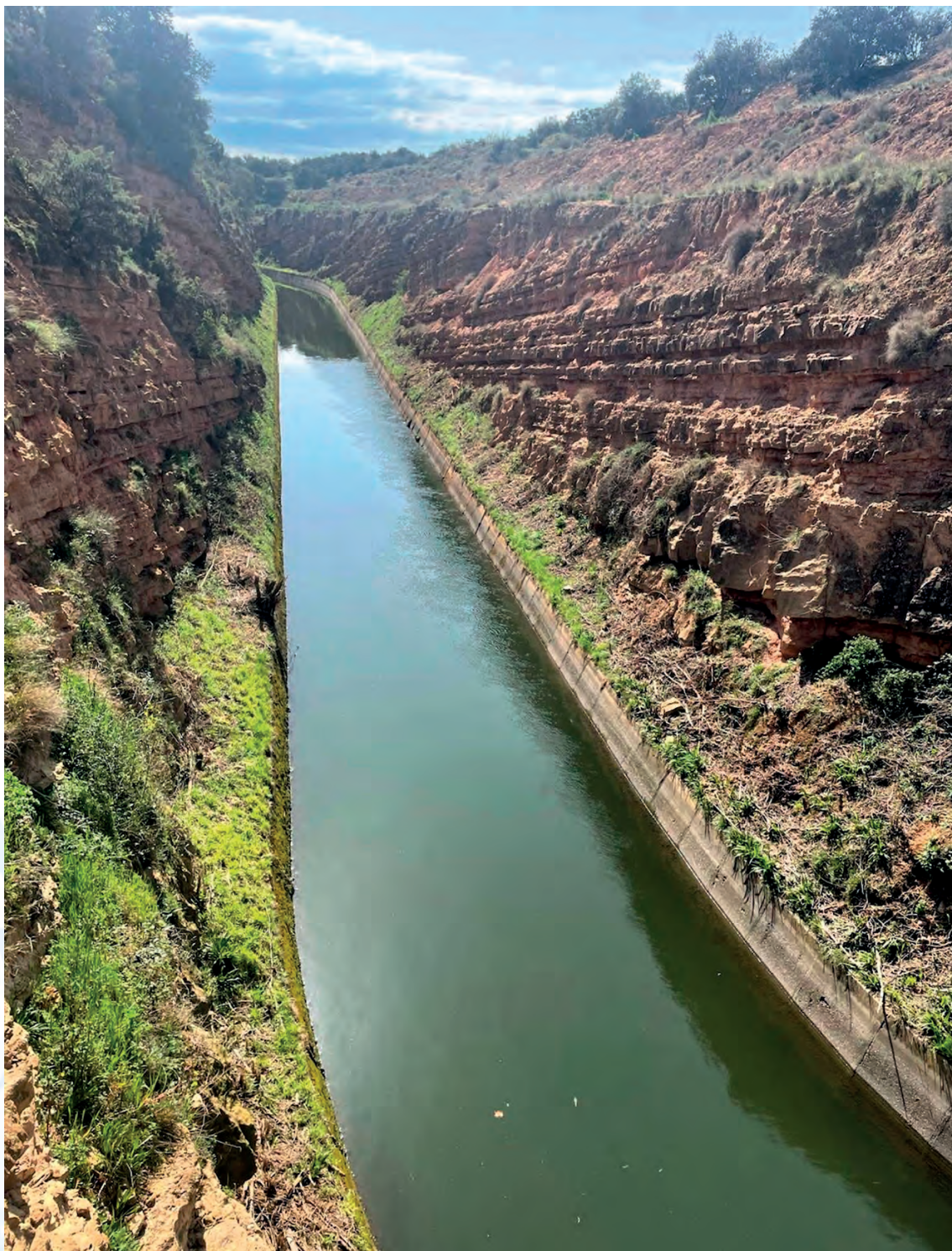
Sortida túnel Montclar.
